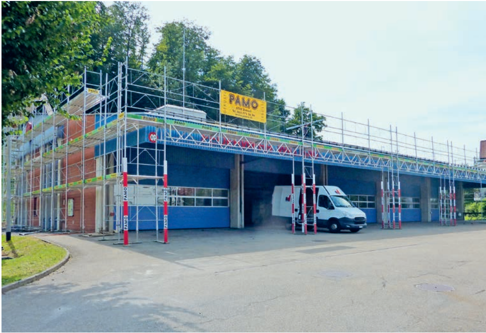
Das eingerüstete Feuerwehrmagazin während der Sanierungsphase.
