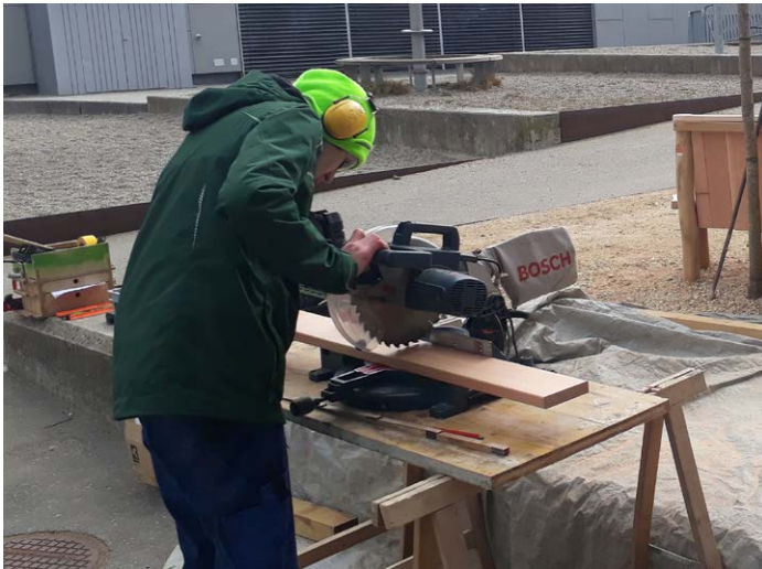
Exaktes Zuschneiden und Befestigen
