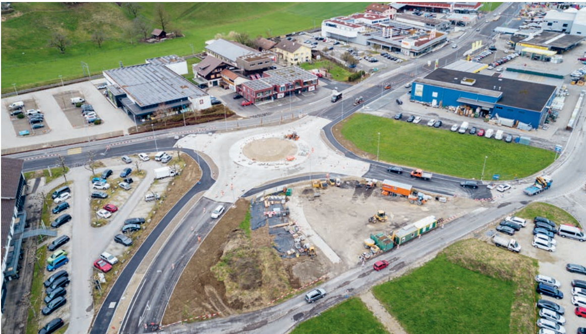
Die Bauarbeiten auf der Kantonsstrasse neigen sich dem Ende zu (Stand März 2024).
