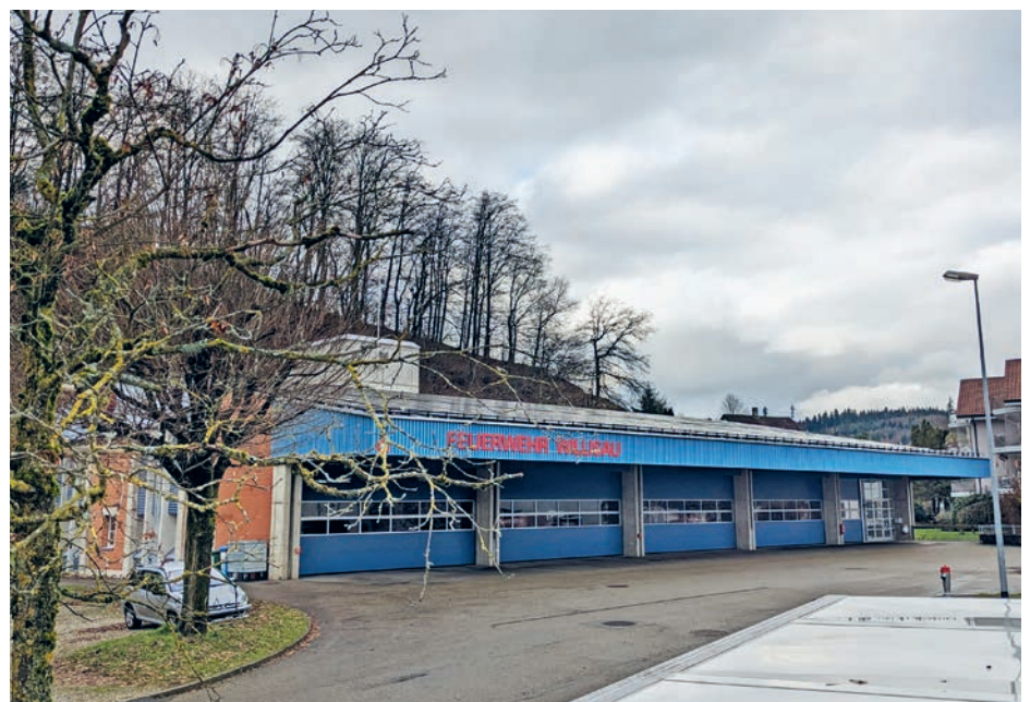
Feuerwehrgebäude mit PV-Anlage.
